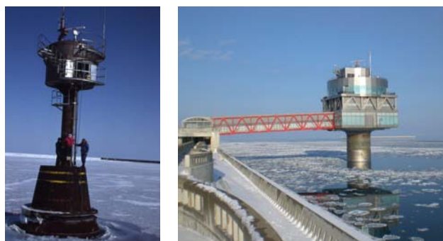
図 16. 油田開発のために氷の圧力を測るために建設された流氷観測タワー(左)と海中展望室も備えた現在のオホーツクタワー(右)。
